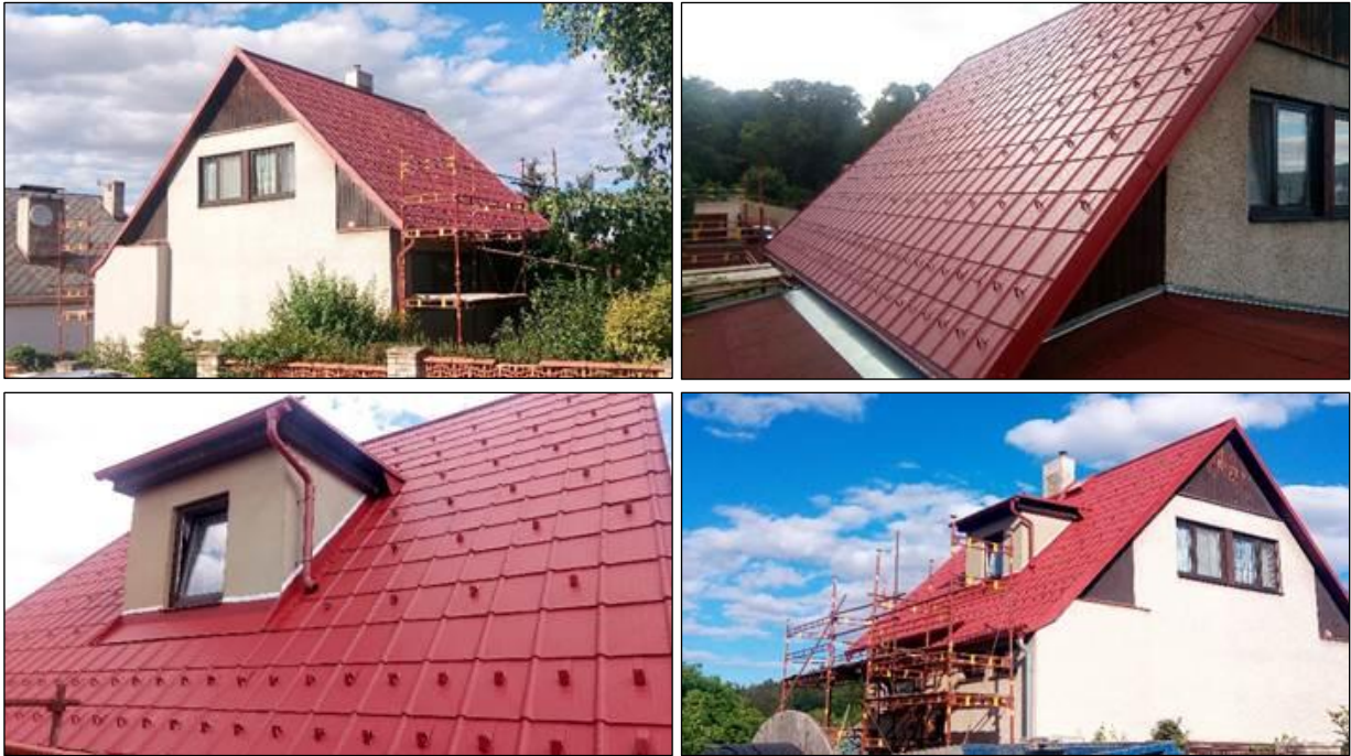
Klempířské práce – rekonstrukce plechové krytiny na rodinném domku
