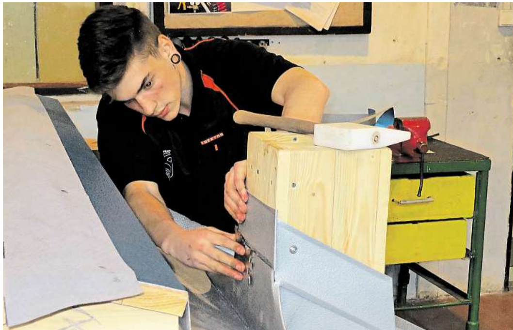
Zkouška střechou Soutěžním úkolem v loňském ročníku Českých ručiček bylo oplechování modelu sedlové střechy s arkýřem a komínem. Provádělo se i spojení štítového lemování ve hřebeni střechy a oplechování hřebene střechy. Na horním snímku Jaroslav Borský při práci. 2x foto: Archiv J. Borského
